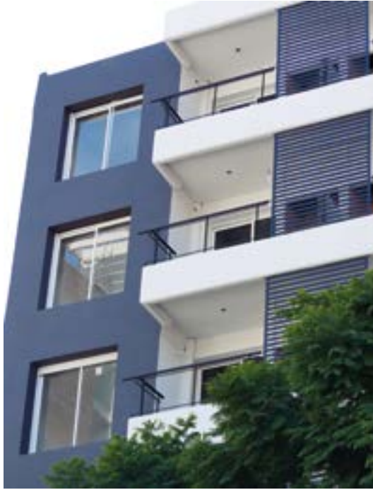
Torre Salta FINALIZADO 2020
